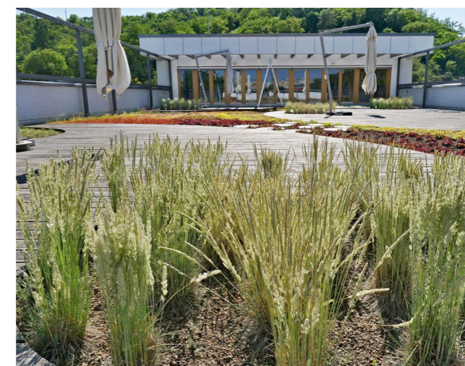
Venkovní učebna na zelené střeše. MŠ a ZŠ Ostopovice.
